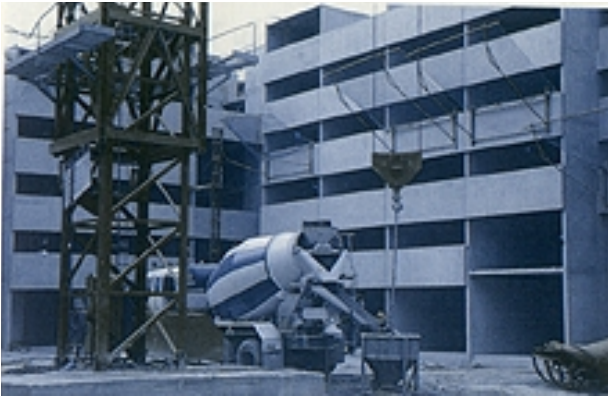
รูปที่ 8.5 การลำเลียงคอนกรีตโดยใช้เครน
