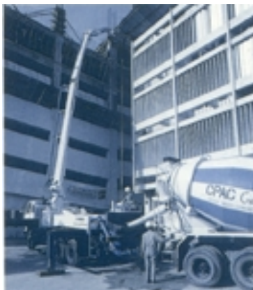
รูปที่ 8.6 การลำเลียงคอนกรีตโดยใช้คอนกรีตปั๊ม
