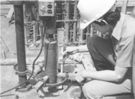
รูปที่ 19.3 งานเจาะคอนกรีตในโครงสร้างเพื่อทดสอบ
