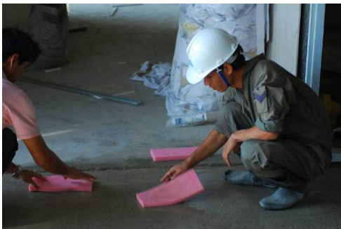
การขังน้ำที่ผิวคอนกรีต
