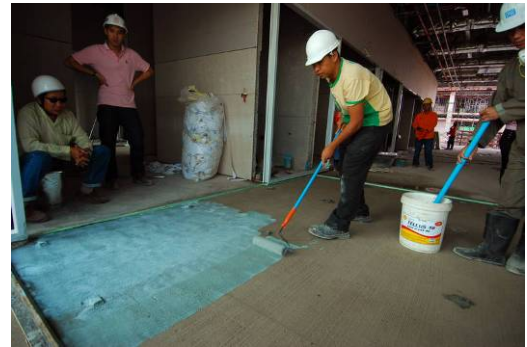
การทาน้ำยาเชื่อมประสานคอนกรีต
