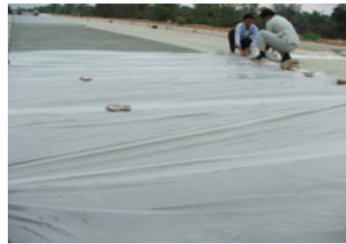
การบ่มคอนกรีตหลังจากเทเสร็จ
