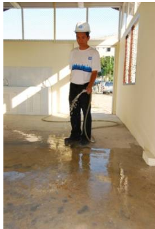
การบ่มคอนกรีตหลังจากคอนกรีตแข็งตัวแล้ว
