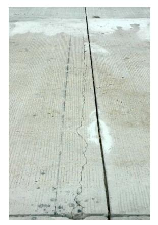
การทำรอยต่อด้วยการใช้เลื่อยตัด (Sawed cut) หากรอย ตัดตื้นเกินไป รอยแตกจะเกิดแบบกระจายทั่วไป
