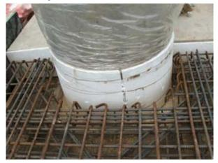
เป็นรอยต่อที่ทำขึ้นเพื่อให้โครงสร้างคอนกรีตส่วนแนวดิ่ง เช่น เสา ผนัง สามารถเลื่อนตัวอย่างอิสระจากโครงสร้างคอนกรีต ในแนวราบ เช่น พื้น เพื่อไม่ให้เกิดการยึดรั้งอันเป็นสาเหตุให้ เกิดการแตกร้าวของโครงสร้างในระยะยาว ส่วนวัสดุที่ใช้ทำรอย ต่อมักใช้วัสดุที่ไม่เปื่อยยุ่ยง่าย ที่นิยมใช้กันมักจะเป็นโฟมหรือ แผ่นยาง โดยจะหุ้มหรือกั้นด้วยวัสดุเหล่านี้ก่อนจะเทคอนกรีต
