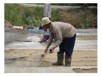
สำหรับโครงสร้างที่ต้องการป้องกันความชื้นจากดินขึ้น สู่พื้น โดยมากต้องทำการปูพลาสติกกันชื้น การปูพลาสติกควร ซ้อนกันอย่างน้อย 0.30 เมตร และมีกาวเชื่อมพลาสติกเพื่อทาบ ต่อกันให้สนิท โดยควรปูภายหลังการผูกเหล็กและก่อนเท คอนกรีต การปูจะต้องยกเหล็กให้ลอยขึ้นแล้วจึงกลิ้งม้วนไปแต่ ถ้าปูพลาสติกกันชื้นก่อน แล้วลงไปผูกเหล็กอาจทำให้พลาสติก ฉีกขาดได้ ส่วนความหนาและชนิดของพลาสติกกันชื้นให้เป็นไป ตามมาตรฐานที่วิศวกรแนะนำ
