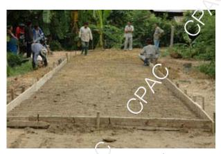
ทำผิวของแบบให้เปียกหรือทาด้วยน้ำมันเสียก่อน เพื่อ ป้องกันการเกาะแบบ ควรทาน้ำมันก่อนการวางเหล็กเสริมเพราะ ถ้าน้ำมันถูกกับเหล็กเสริมจะเป็นการทำลายแรงยึดเหนี่ยวระหว่าง คอนกรีตกับเหล็กเสริม วิธีที่ดีเพื่อรักษาแบบไม้ให้แน่นและ ป้องกันการบิดงอคือให้แบบนั้นชุ่มน้ำอยู่ตลอดเวลาก่อนที่จะเท คอนกรีต ไม้ที่ยังสดเกินไปอาจจะหดตัวได้แต่ถ้าไม้นั้นแห้ง เกินไปอาจจะเกิดการงอหรือบิดเมื่อเปียก
