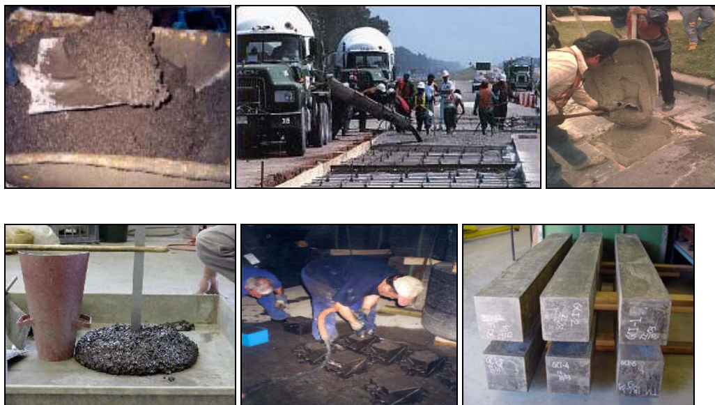
Fig. 8 แสดงการนำไปใช้งานโครงสร้างคอนกรีตและงานซ่อมถนนของวัสดุ Geopolymer
