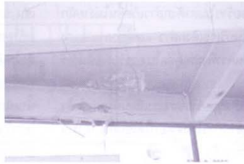
รูปที่ 8 แสดงรอยรั่วในพื้นที่และคานจากสนิมเหล็ก
