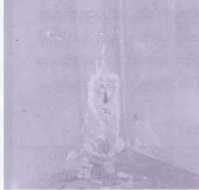
รูปที่ 5 แสดงรอยร้าวในเสาจากสนิมเหล็กและการรับแรงเกินกำลัง
