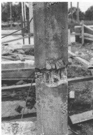
รูปที่ 2 ลูกปูน 2 ลูกมาติดกัน เสาที่ถอดแบบเห็นเหล็กได้อย่างชัดเจน
