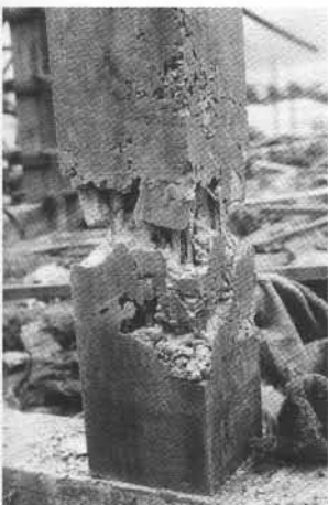
รูปที่ 1 ลูกปูนที่ใหญ่เกินไป จะขวางคอนกรีตที่เทลงแบบ
