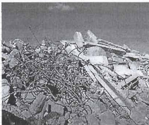
รูปที่ 1 แหล่งที่มาของวัสดุเหลือใช้จากการก่อสร้างและทุบทำลาย (ก) ถนนคอนกรีต (ข) โครงสร้างคอนกรีตเสริมเหล็ก
