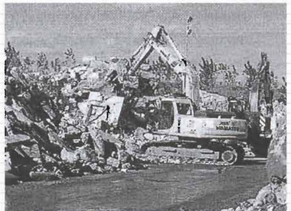
รูปที่ 3 การลดขนาดคอนกรีตที่ได้จากการทุบทำลายก่อนเข้าสู่กระบวนการผลิตมวลรวมที่นำกลับไปใช้ใหม่
