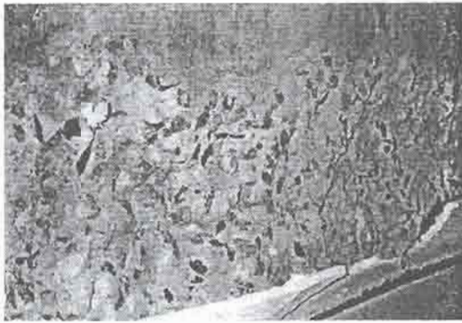
รูปที่ 9 ลักษณะคอนกรีตที่เกิดการ Spalling เมื่อสัมผัสกับอุณหภูมิสูงอย่างกะทันหัน
