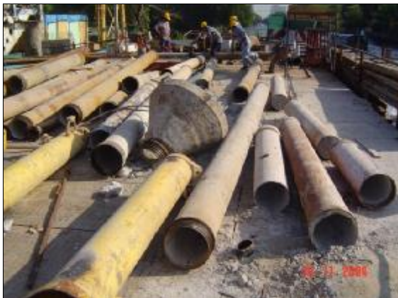
รูปที่ 3 ท่อ Tremie ที่ใช้เทคอนกรีตได้น้ำ
