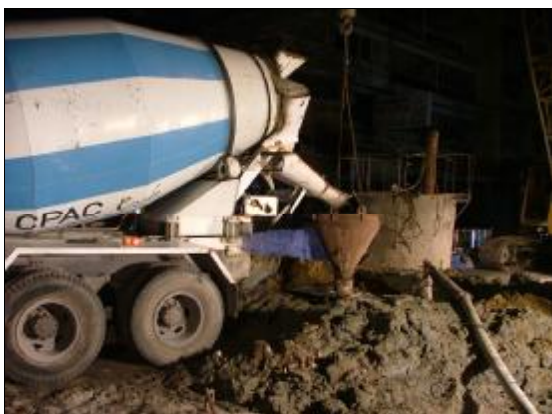
รูปที่ 31 การเทคอนกรีตสำหรับงานปรับปรุงคุณภาพดิน ด้วยวิธี Cement Column
