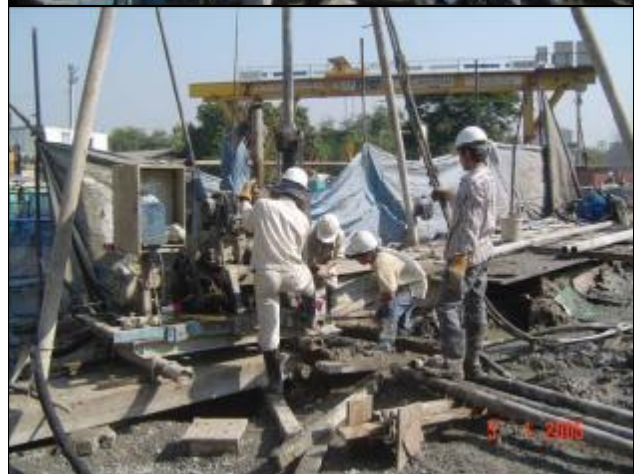
รูปที่ 32 , 33 การปรับปรุงสภาพดินด้วยวิธี Grout Cement Column ระหว่างเข็มเจาะ เพื่อป้องกันน้ำใต้ดินไหลเข้า ปล่องอุโมงค์
