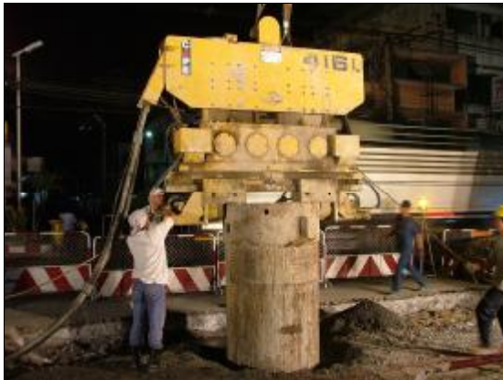
รูปที่ 29 การฝังท่อ Casting เข็มเจาะหน้าปล่อง (Block out) สำหรับงานปรับปรุงคุณภาพดิน
