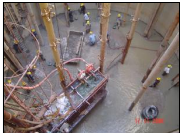
รูปที่ 14 การสูบน้ำออกเพื่อตรวจสอบคอนกรีตใต้น้ำที่เท
