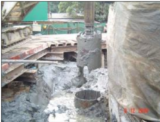
รูปที่ 30 การขุดดินจาก Casting เข็มเจาะ
