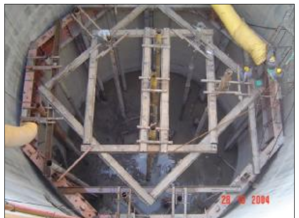
รูปที่ 1 โครงสร้างปล่องไต้ดินที่จะเทคอนกรีตใต้น้ำ
