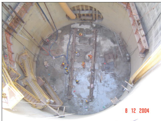
รูปที่ 15 ก่อน Coring ของคอนกรีตใต้น้ำที่เท
