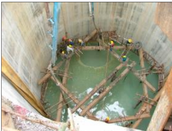
รูปที่ 9 , 10 , 11 การเทคอนกรีตใต้น้ำโดยใช้ Pump ผ่านท่อ Tremie
