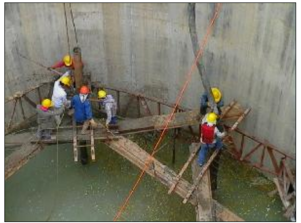
รูปที่ 12 การเทคอนกรีตใต้น้ำและการดึงท่อ Tremie ขึ้น เพื่อป้องกันท่อติดกับคอนกรีตที่เทไปแล้ว
