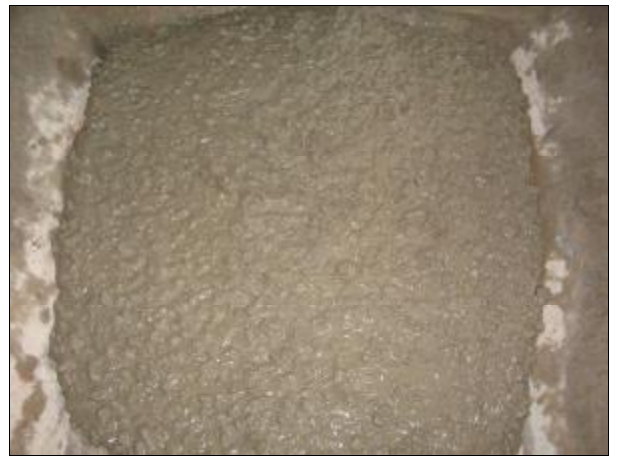
รูปที่ 7 สภาพเนื้อคอนกรีตสำหรับเทได้น้ำ
