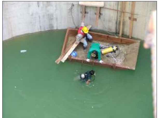
รูปที่ 13 ทีมประดาน้ำสำรวจความลึกของน้ำ เพื่อคำนวณระยะฝังท่อ Tremie ให้เหมาะสม
