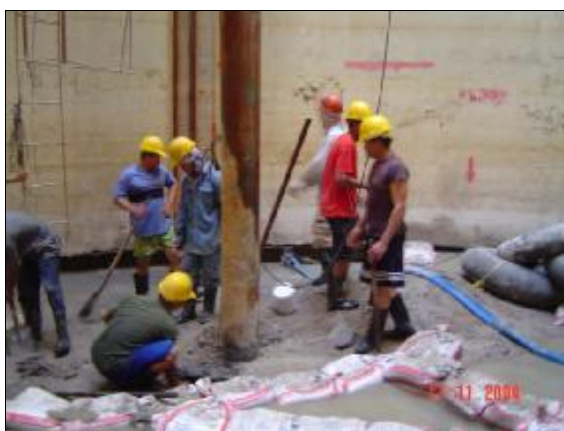
รูปที่ 2 ปัญหาท่อ Tremie ที่ใช้ในการเทคอนกรีตติดกับคอนกรีตที่เทไปแล้ว
