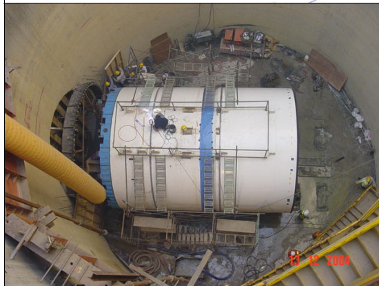
รูปที่ 16,17 การติดตั้ง Guide หัวเจาะ และหัวเจาะ อุโมงค์
