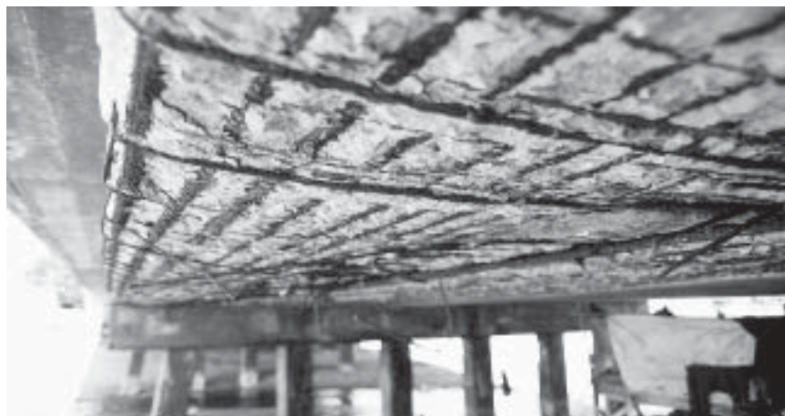
รูปที่ 10-4 พื้นสะพานคอนกรีตเสริมเหล็กที่ตั้งอยู่ใกล้ทะเล ได้รับความเสียหายอย่างรุนแรง เนื่องจากการกระทำของคลอไรด์
