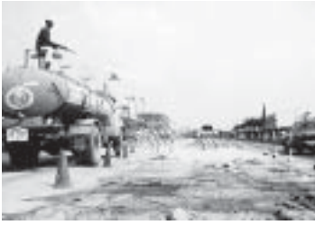
รูปที่ 10-2 น้ำบ่มคอนกรีตใช้บ่มคอนกรีตให้มีกำลังเพิ่มขึ้นและเป็นการป้องกันปัญหาการแตกร้าวเนื่องจากการสูญเสียน้ำของคอนกรีต
