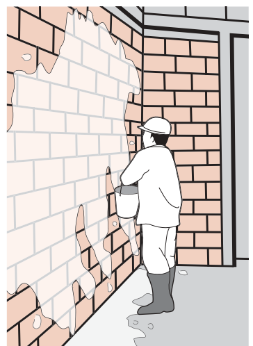
รูปที่ 6-20 เมื่อผิวปูนก่อแห้งแล้ว ควรทำการบ่มอย่างน้อย 7 วัน
