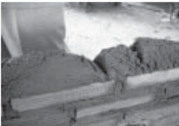
ข) ลักษณะเนื้อปูนก่อที่มีการยัดเกาะก้อนอิฐได้ไม่ดี
