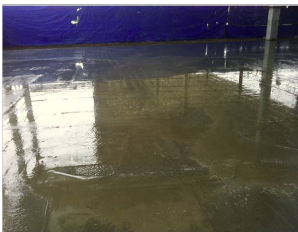
รูปที่ 1 คอนกรีตที่มีส่วนผสมน้ำมากเกินไป ทำให้เกิดการเยิ้ม น้ำได้ง่าย
