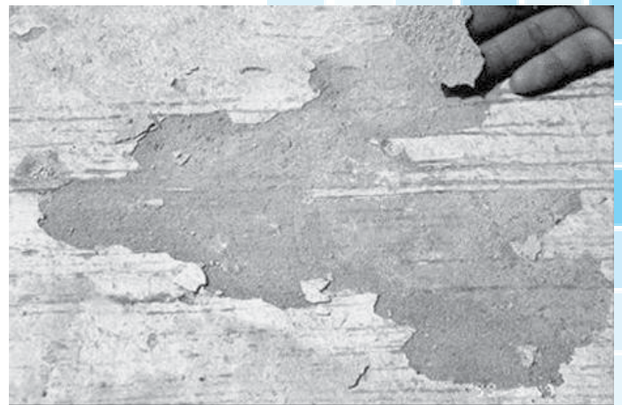
รูปที่ 4 Laitance ที่ผิวด้านบนของคอนกรีตสาเหตุหลักมาจากการใช้ทรายที่มีความละเอียดมากโดยมีฝุ่นขนาดเล็กกว่า 75 micron (No. 200 sieve) มากกว่า 5 เปอร์เซ็นต์ และคอนกรีตเหลวมากเกินไป
