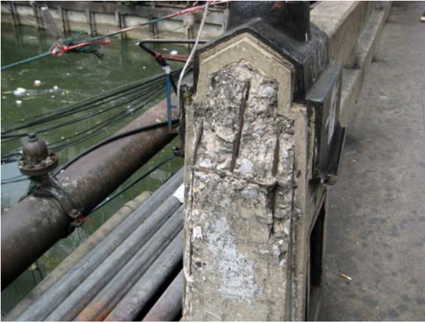
สภาพของโครงสร้างคอนกรีตเสริมเหล็กที่เกิดปฏิกิริยาคาร์บอนเนชั่น
