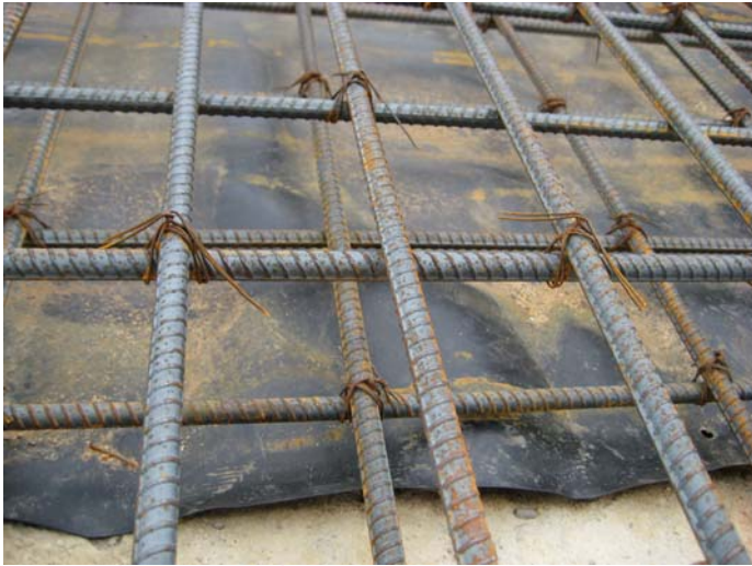
การปูแผ่นพลาสติกก่อนการเทคอนกรีต
