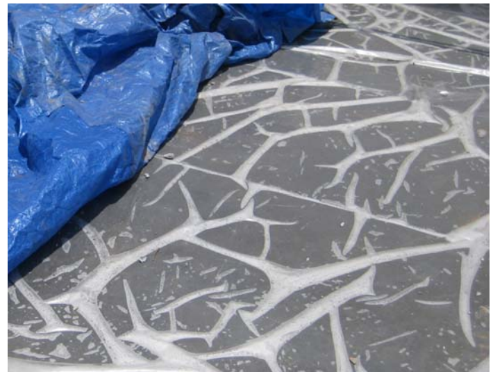
การบ่มคอนกรีตด้วยวิธีการใช้แผ่นพลาสติกคลุมแล้วหมั่นฉีดน้ำให้ชุ่ม
