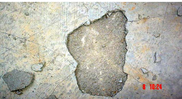
การลอกร่อนของชั้น Floor Hardener
