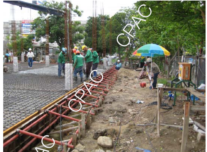
การใช้กล่องระดับเพื่อหาระดับในการเทพื้นคอนกรีต
