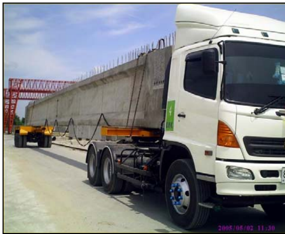
รูปที่ 25 การขนส่ง Girder ไปติดตั้งยังโครงการก่อสร้าง
