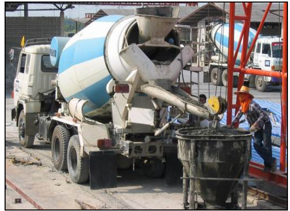
รูปที่ 21 การจัดส่งคอนกรีตให้กับหน่วยงาน
