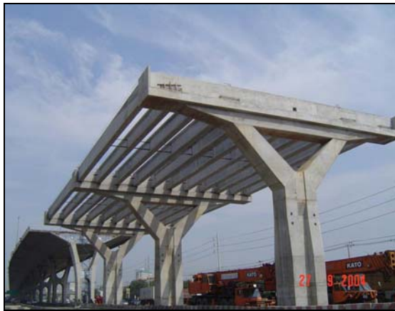
รูปที่ 1 คานสะพานอัดแรงของโครงการทางด่วนขั้นที่ 3 สายใต้ ตอน S1
