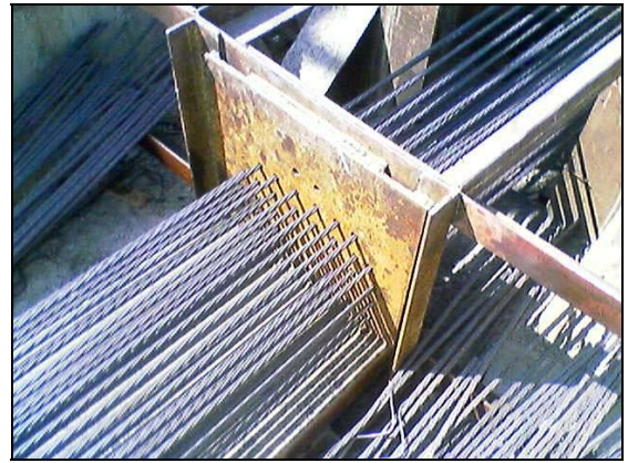
รูปที่ 2 การดึงลวดอัดแรงตามระบบ Pre-Tension
