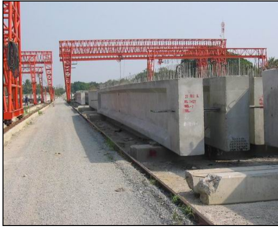
รูปที่ 24 Girder ที่หล่อแล้วเสร็จพร้อมขนส่งไปติดตั้ง
