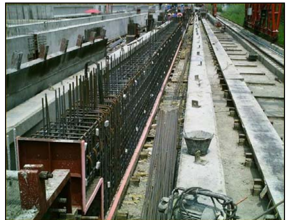
รูปที่ 3 การผูกเหล็กเสริมและลวดอัดแรงก่อนเข้าแบบ
