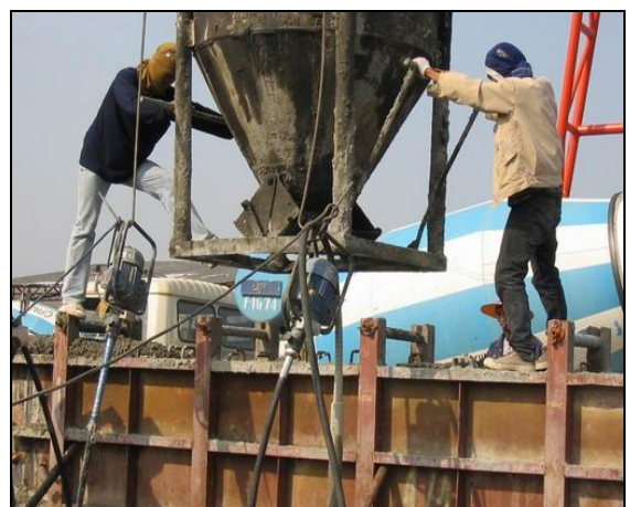
รูปที่ 23 การเทคอนกรีตลงแบบหล่อ Girder
