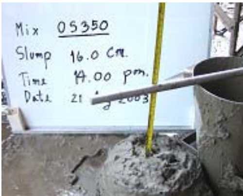
รูปที่ 15 ค่ายุบตัวเบื้องต้น 16.0 ซม. คอนกรีตกำลังอัด 350 กก./ตร.ซม.
