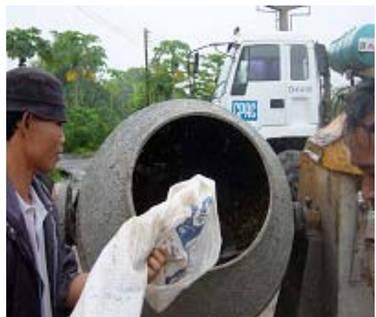
รูปที่ 13 การทดสอบส่วนผสมคอนกรีต โดยใช้โมเล็ก
