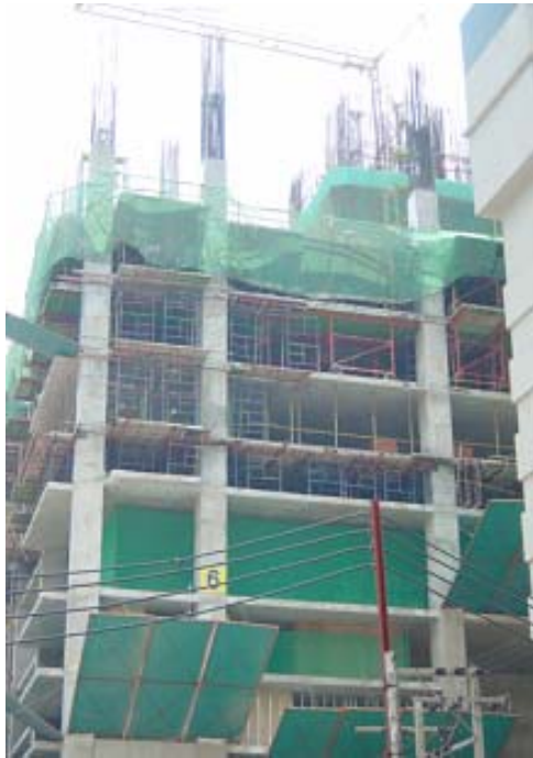
รูปที่ 5 , 6 โครงการก่อสร้างอาคารประสานมิตรธานี ซึ่งมีการใช้งาน SLIPFORM สำหรับโครงสร้างปล่อง ลิฟท์
