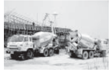
รูปที่ 17-12 รถผสมคอนกรีตมีความจุคันละ 5 ลูกบาศก์เมตร
