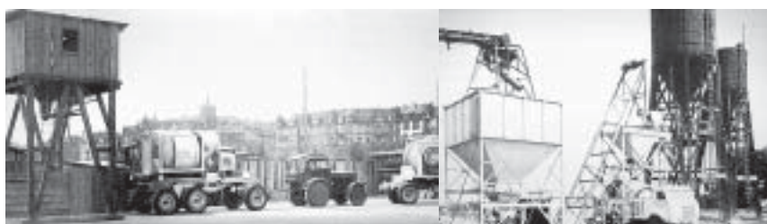
รูปที่ 17-4 โรงงานคอนกรีตผสมเสร็จในยุคแรก ๆ
