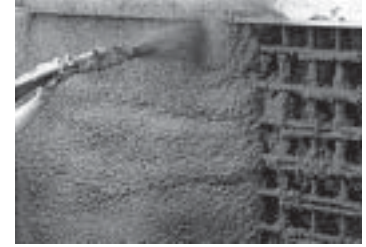
รูปที่ 13-36 เทคนิคการใช้ท้ออัดฉีด (Shotcreting) ในการเทผนัง
