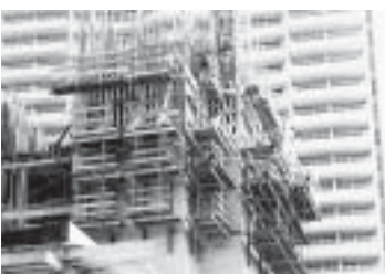
รูปที่ 13-35 การใช้แบบหล่อเคลื่อนที่ (Slipforming) ในการก่อสร้างอาคารสูง
