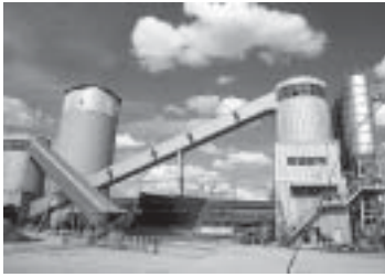
รูปที่ 13-11 การผสมคอนกรีตด้วยเครื่องจักร เหมาะสำหรับใช้ในโรงงานอุตสาหกรรมคอนกรีต
