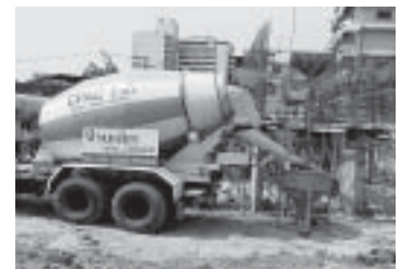
ก) คายคอนกรีตจากรถโมโตไซด์ในถังเหล็ก
