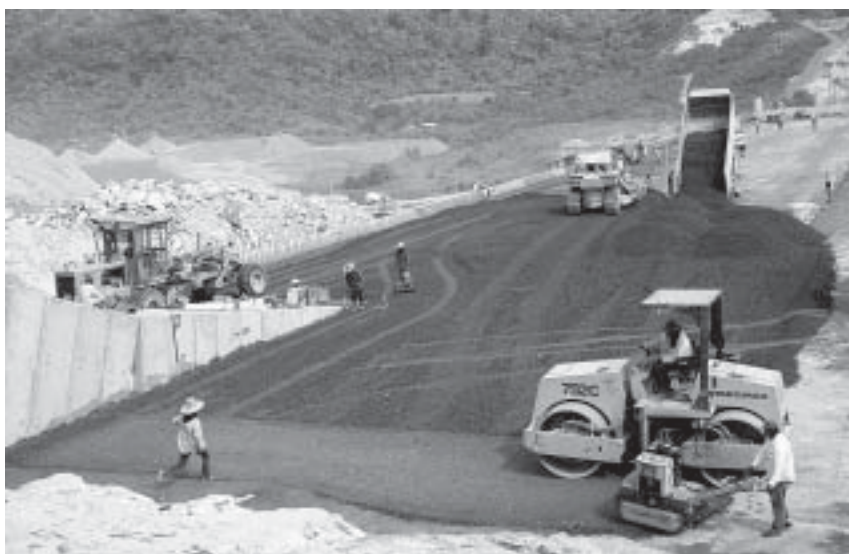
ก) สภาพการก่อสร้างเขื่อนคอนกรีตบดอัด
