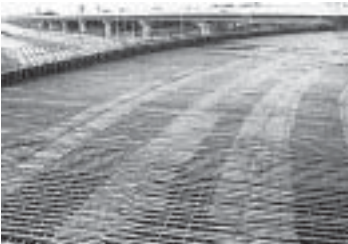
รูปที่ 13-34 การเทคอนกรีตเข้าไปในแบบหล่อที่มีเหล็กเสริมหนาแน่นมาก ควรระมัดระวังไม่ให้คอนกรีตตกกระทบกับเหล็กเสริม เพราะอาจทำให้คอนกรีตแยกตัวได้
