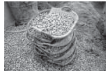
รูปที่ 13-5 งานก่อสร้างขนาดเล็ก มักนิยมใช้การตวงปริมาตรมวลรวมด้วยบุงกี ซึ่งเป็นวิธีการวัดที่มีความไม่แน่นอนสูง ทำให้มักได้คอนกรีตที่มีกำลังอัดต่ำ และมีคุณภาพไม่สม่ำเสมอ
