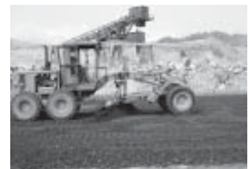
ค) การเกลี่ย RCC เป็นชั้น ๆ ด้วยรถมอเตอร์เกรดเดอร์
