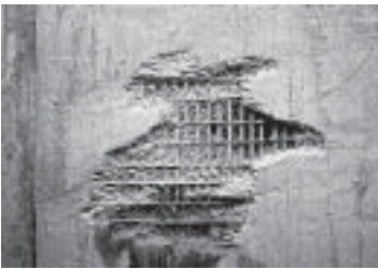
รูปที่ 13-39 ผิวคอนกรีตเป็นรูโพรง (Honeycomb)
