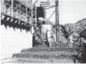
รูปที่ 13-32 การเทคอนกรีตเป็นชั้น ๆ อย่างสม่ำเสมอ 9
