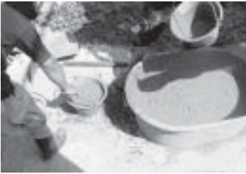
รูปที่ 13-15 การลำเลียงคอนกรีต โดยใช้คนหิ้วถังใส่คอนกรีต
