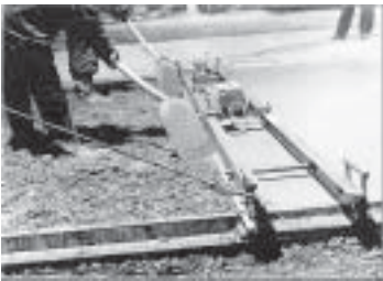
ข) Vibrating Screed ชนิดคานคู่
