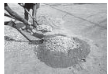
รูปที่ 13-9 การผสมคอนกรีตด้วยมือ
