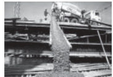
ข) การลำเลียงและการเทคอนกรีตผ่านราง
