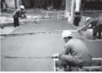
รูปที่ 13-46 การแต่งผิวหน้าคอนกรีต
