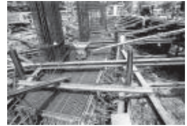
ก) การเตรียมรางก่อนการเท
