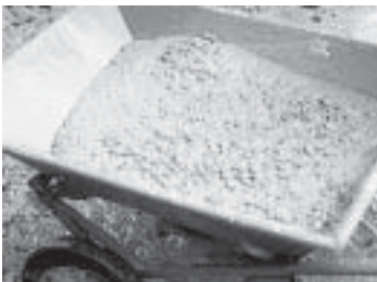
รูปที่ 13-16 การลำเลียงคอนกรีต โดยใช้รถเข็น
