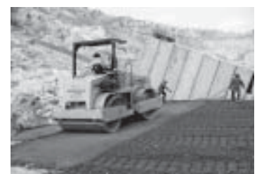
ง) การบดอัด RCC ให้แน่นด้วยรถบดล้อเหล็ก
