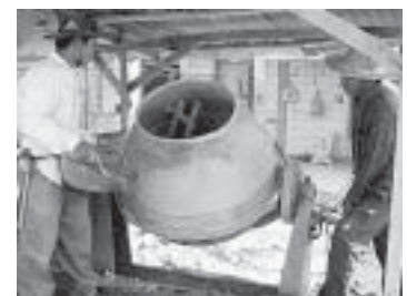
รูปที่ 13-10 การผสมคอนกรีตด้วยมือขนาดเล็ก
