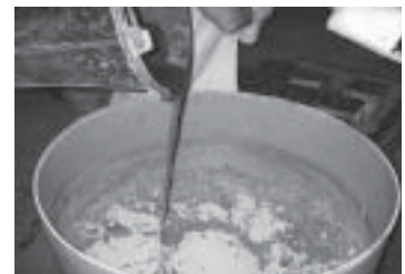
รูปที่ 12-27 การเทน้ำซึ่งได้ผสมกับน้ำยาก่อนแล้วลงในเครื่องผสมซึ่งได้ใส่หินทราย และปูนซีเมนต์ก่อนแล้ว
