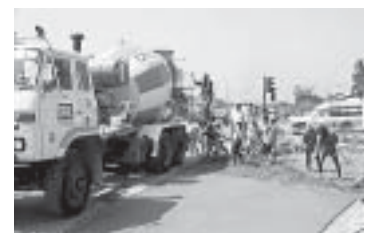
รูปที่ 12-33 การเทคอนกรีตงานถนนโดยทั่วไป ใช้คอนกรีตที่มีค่ายุบตัว 7.5 \pm 2.5 เซนติเมตร
