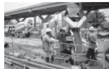
รูปที่ 12-34 การเทคอนกรีตงานเสาเข็มเจาะขนาดใหญ่ คอนกรีตควรมีค่ายุบตัวมากกว่า 15 เซนติเมตร
