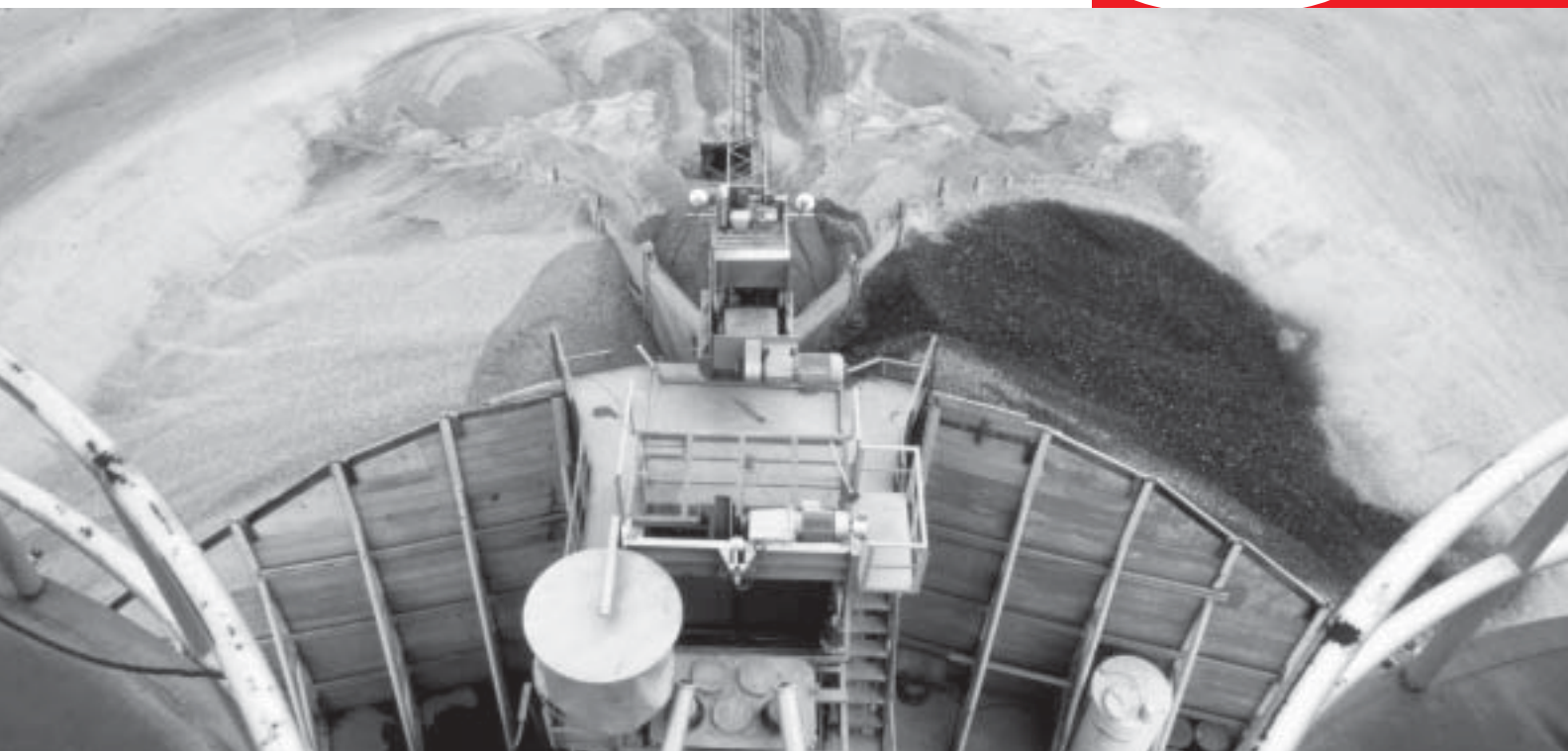
รูปที่ 9-1 การกองเก็บมวลรวมในโรงงานอุตสาหกรรมคอนกรีต
