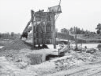
รูปที่ 9-24 การผลิตทรายตามวิธีการดั้งเดิม โดยใช้ตะแกรงแยกขนาดทราย
