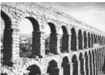
รูปที่ 8-5 สะพานสำหรับการส่งน้ำในสมัยโรมัน 7
