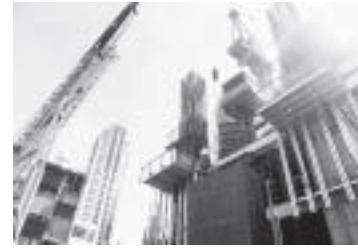
รูปที่ 8-18 การก่อสร้างอาคารสูงในประเทศไทยโดยใช้คอนกรีตกำลังสูง
