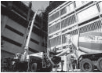
รูปที่ 8-11 คอนกรีตปั๊ม
