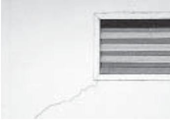
รูปที่ 7-27 ผนังแตกร้าวที่มุมวงกบหน้าต่างในแนวทแยง เนื่องจากไม่ได้เสริมตะแกรงกรงไก่
