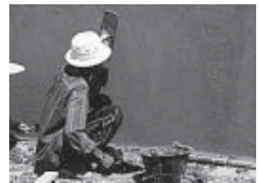
รูปที่ 7-9 ควรหลีกเลี่ยงการฉาบบนผิวผนังที่สัมผัสแสงแดดจัดโดยตรง
