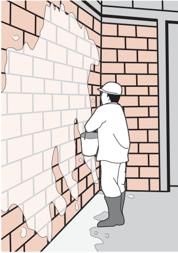
รูปที่ 7-17 การรดน้ำผนังอย่างเพียงพอและทั่วถึง ก่อนทำการฉาบ
