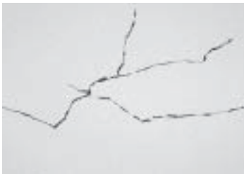
รูปที่ 7-28 ลักษณะรอยแตกร้าวแบบแผนที่
