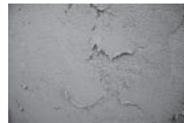
ข) เนื้อปูนฉาบที่มีการยึดเกาะกันไม่ดี
